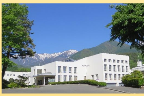
養命酒製造(株)駒ヶ根工場 ↑ (写真提供 養命酒製造(株))
